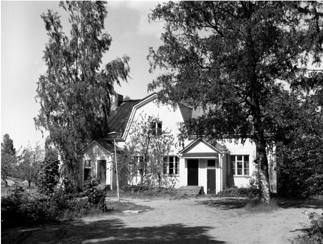
Kuva 15. Isännöitsijän talo 1986–1987 (Lappeenrannan museot, Etelä-Karjalan rakennuskulttuuri –inventointi kuvaaja Arto Hämäläinen).
