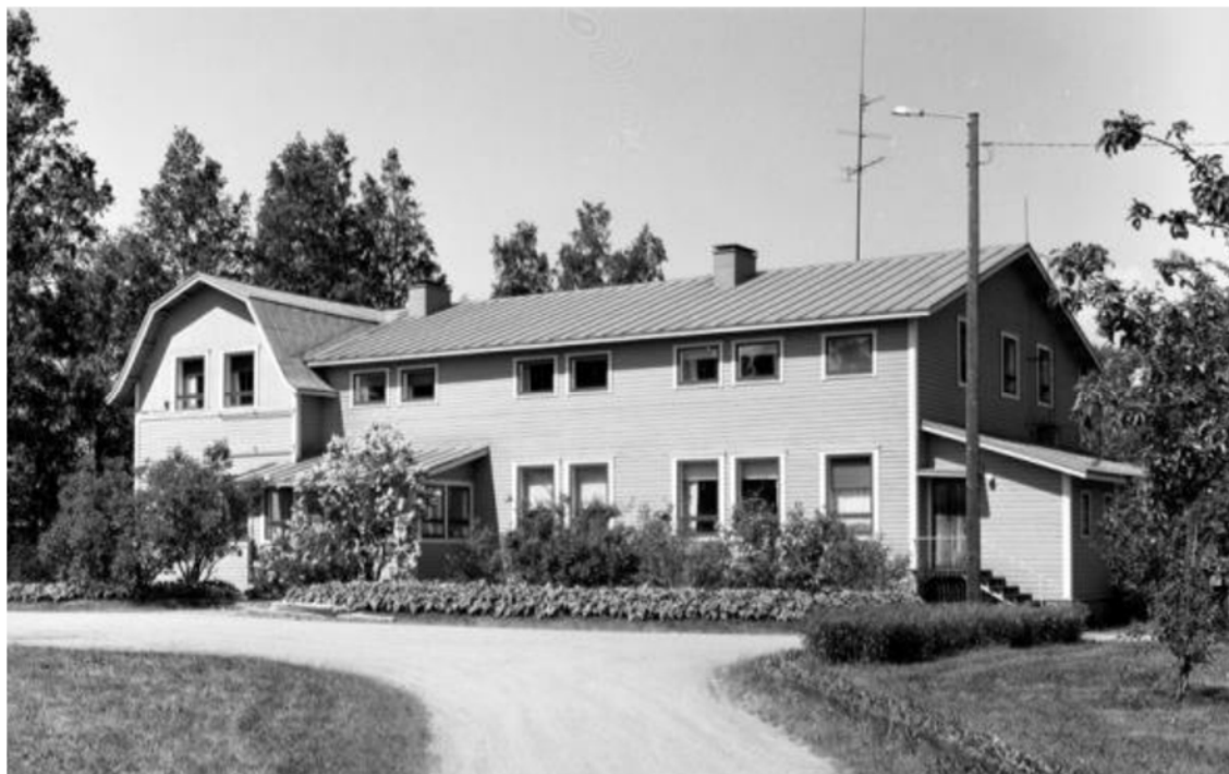
Kuva 9. Kerhola 1986-87 (Lappeenrannan museot, Etelä-Karjalan rakennuskulttuuri –inventointi. Kuvaaja Arto Hämäläinen).
